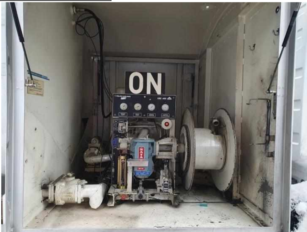
Fot. 31. Wnętrze zabudowy
